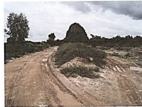
รูปที่ 5 แสดงคันกันดิน โดยที่ใช้เศษหินและดินปรับแต่งเป็นแนวคันกันดิน บริเวณด้านตะวันออกทางเข้าโครงการฯ
